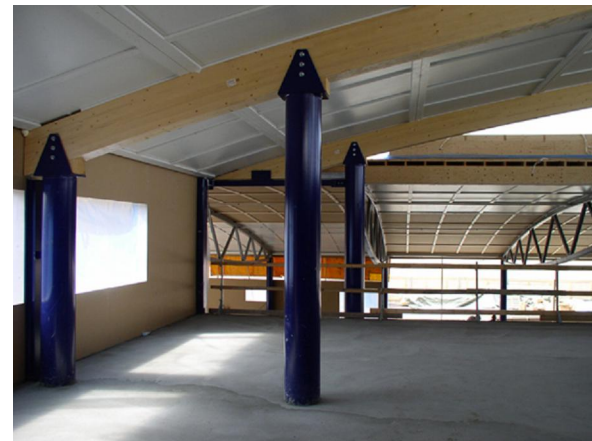
Kittilän lentoasema, työmaavaihe 2007
